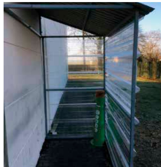
Composteur et borne TchaoMegot installés sur nos sites
